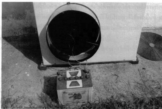
ภาพที่ 23 แสดงขั้นตอนการประกอบชุดผลิตไฟฟ้าจากคอมเพรสเซอร์เครื่องปรับอากาศ
