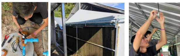
รูปที่ 4 การติดตั้งอุปกรณ์ระบบควบคุมอุณหภูมิและความชื้นในโรงเรือน
