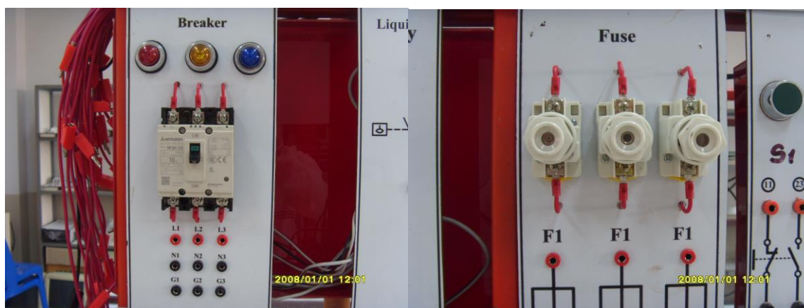
ภาพที่ 3.7 เมนเบรกเกอร์ และอุปกรณ์ป้องกัน
