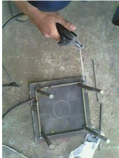
ภาพที่ 3-6 การทำฐานที่ยึดเสาไฟ
