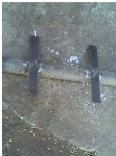
ภาพที่ 3-5 การทำขาจับตู้ควบคุม
