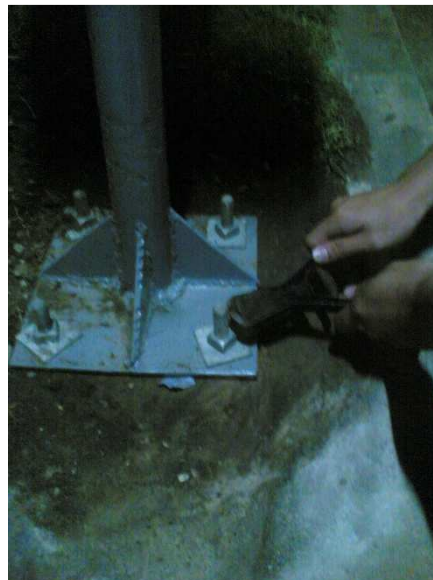
ภาพที่ 3-7 การยึดสกรูเสาไฟ
