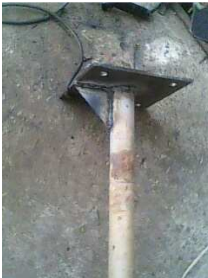
ภาพที่ 3-4 การเชื่อมเสาดูดกับฐานเหล็ก
