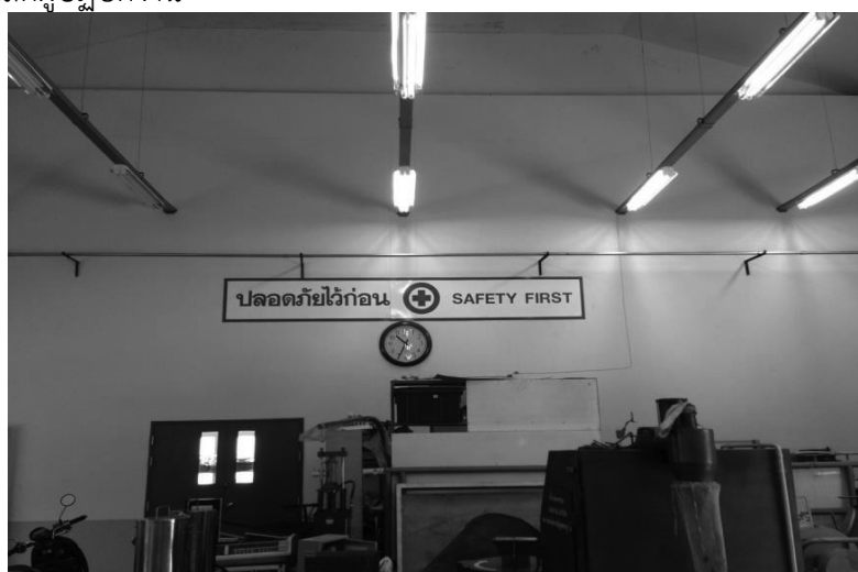
ภาพที่ 4.4 หลังการติดป้ายความปลอดภัย
