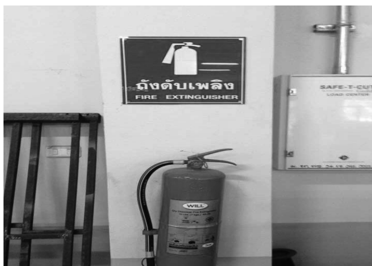
ภาพที่ 4.6 หลังการติดป้ายถังดับเพลิง
