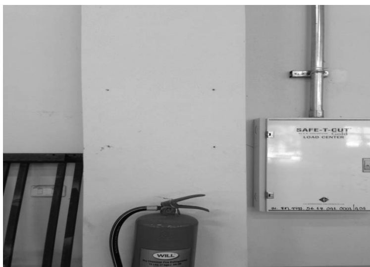
ภาพที่ 4.5 ก่อนการติดป้ายถังดับเพลิง
