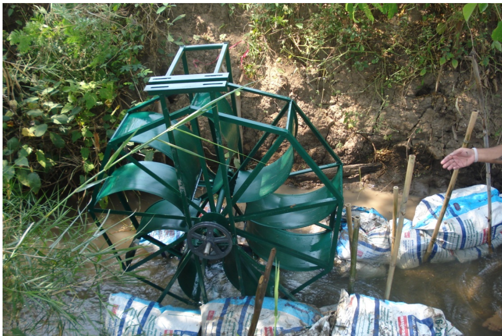
การติดตั้งกังหันน้ำ
