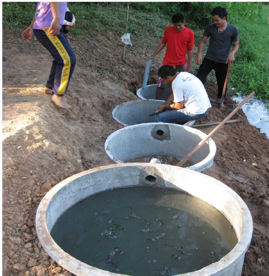
ภาพที่ 3.6 สร้างถังรับน้ำทิ้งจากถังเกรอะอาคาร โดยมี 3 ระดับ ได้แก่ ระดับที่ 1 เป็นถังกรองด้วยถ่าน ระดับที่ 2 เป็นถังตกตะกอนและเทราดน้ำหมักชีวภาพ และระดับที่ 3 ถังดักสารพิษด้วยการปลูกต้นกก ก่อนปล่อยน้ำลงในบ่อ
