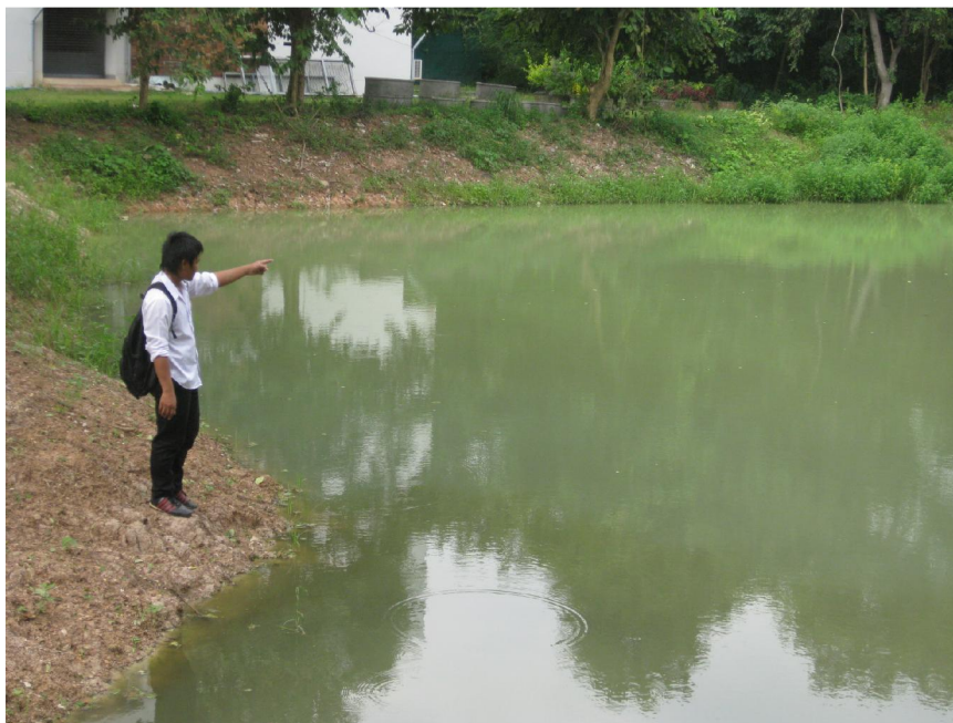
ภาพที่ 3.4 ขุดลอกบ่อใหม่ให้มีความจุไม่น้อยกว่า 600 ลูกบาศก์เมตร และทำคันดินสูง 1 เมตร กว้าง 3 เมตรโดยรอบ
