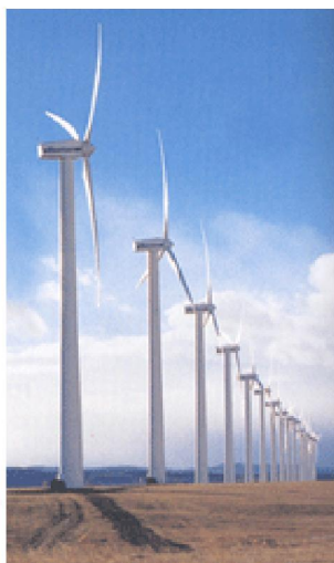
ภาพที่ 2.7 กังหันลมแบบแนวแกนนอน (Horizontal Axis Wind Turbine) (ที่มา การไฟฟ้าฝ่ายผลิตแห่งประเทศไทย 2554)
