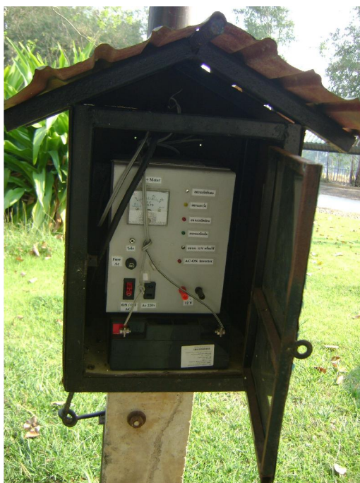
ภาพที่ 3.5 การติดตั้งวงจรประจุไฟฟ้าพร้อมอินเวอร์เตอร์ อาคารคณะเทคโนโลยีการเกษตร
