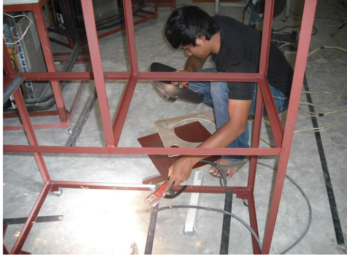
ภาพที่ 3.18 ภาพถ่ายการเชื่อมโครงสร้าง
