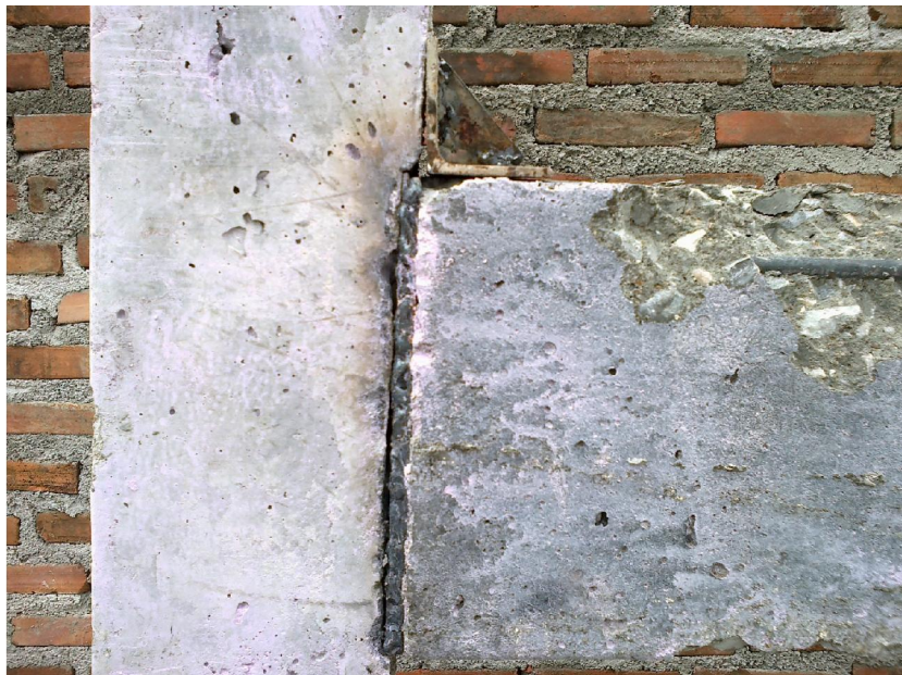
รูปที่ ก4 ลักษณะการรื้อตัวของคาน B4
