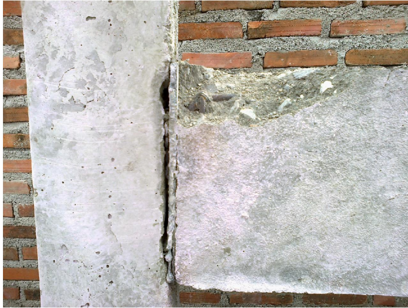
รูปที่ ก3 ลักษณะการรื้อตัวของคาน B3
