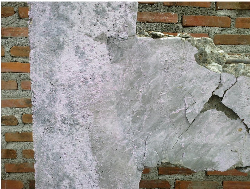
รูปที่ ก2 ลักษณะการวิบัติของคาน B2
