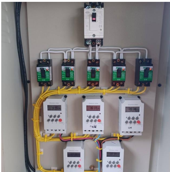
รูปที่ 3-6 วงจรระบบควบคุมไฟฟ้าโรงเรือนอัจฉริยะสำหรับการปลูกกล้วยงเพื่อผลิตเมล็ดพันธุ์และเส้นใย
