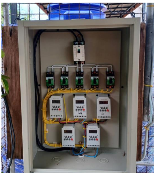
รูปที่ 4-5 การทดลองการระบบควบคุมโรงเรือนอัจฉริยะสำหรับการปลูกกล้วยงเพื่อผลิตเมล็ดพันธุ์และเส้นใย
