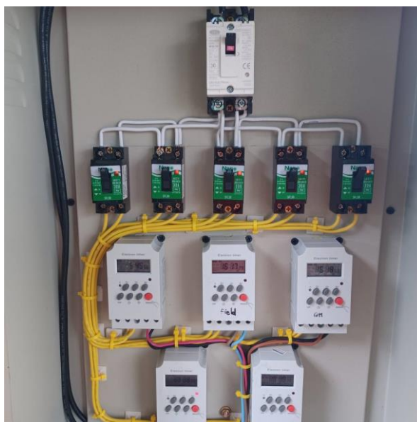
รูปที่ 4-4 การวางอุปกรณ์ควบคุมโรงเรือนอัจฉริยะสำหรับการปลูกกล้วยงเพื่อผลิตเมล็ดพันธุ์และเส้นใย
