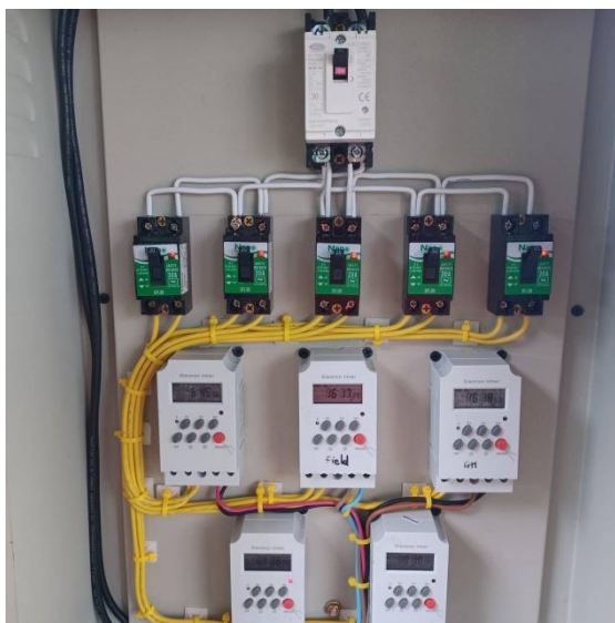
รูปที่ ก-6 ระบบควบคุมการให้น้ำในโรงเรือนอัจฉริยะสำหรับการปลูกกล้วยงเพื่อผลิตเมล็ดพันธุ์และเส้นใย
