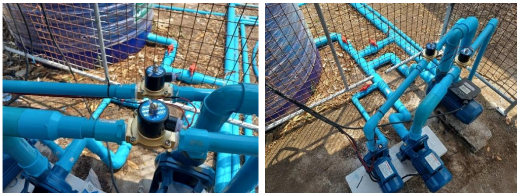
รูปที่ ก-5 ระบบควบคุมการให้น้ำในโรงเรือนอัจฉริยะสำหรับการปลูกกล้วยงเพื่อผลิตเมล็ดพันธุ์และเส้นใย
