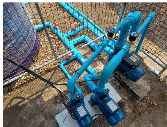
รูปที่ 3-5 ระบบควบคุมการให้น้ำในโรงเรือนอัจฉริยะสำหรับการปลูกกล้วยงเพื่อผลิตเมล็ดพันธุ์และเส้นใย
