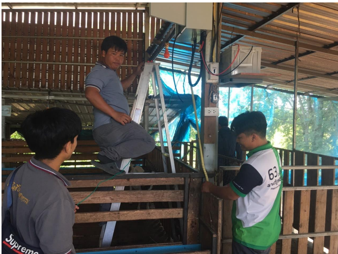
ภาพที่ 4.69 การติดตั้งระบบป้องกันและสายดิน
