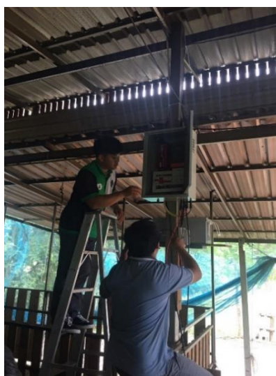
ภาพที่ 4.65 การติดตั้ง กล่องควบคุมและการต่อสาย DC cable
