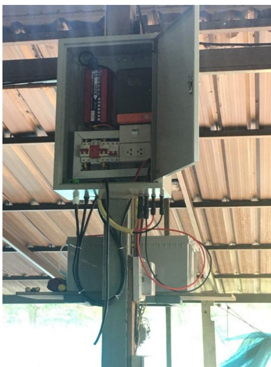
ภาพที่ 4.71 ภาพโดยรวมของระบบผลิตไฟฟ้าแบบผสมผสานเซลล์แสงอาทิตย์และชุดกักเก็บพลังงาน
