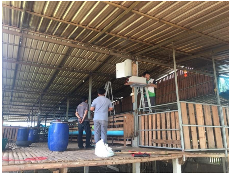
ภาพที่ 4.68 การติดตั้งชุดแบตเตอรี่
