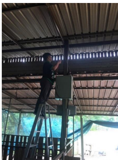
ภาพที่ 4.64 การลากสาย DC cable จากแผงโซลาร์เข้ากล่องควบคุม
