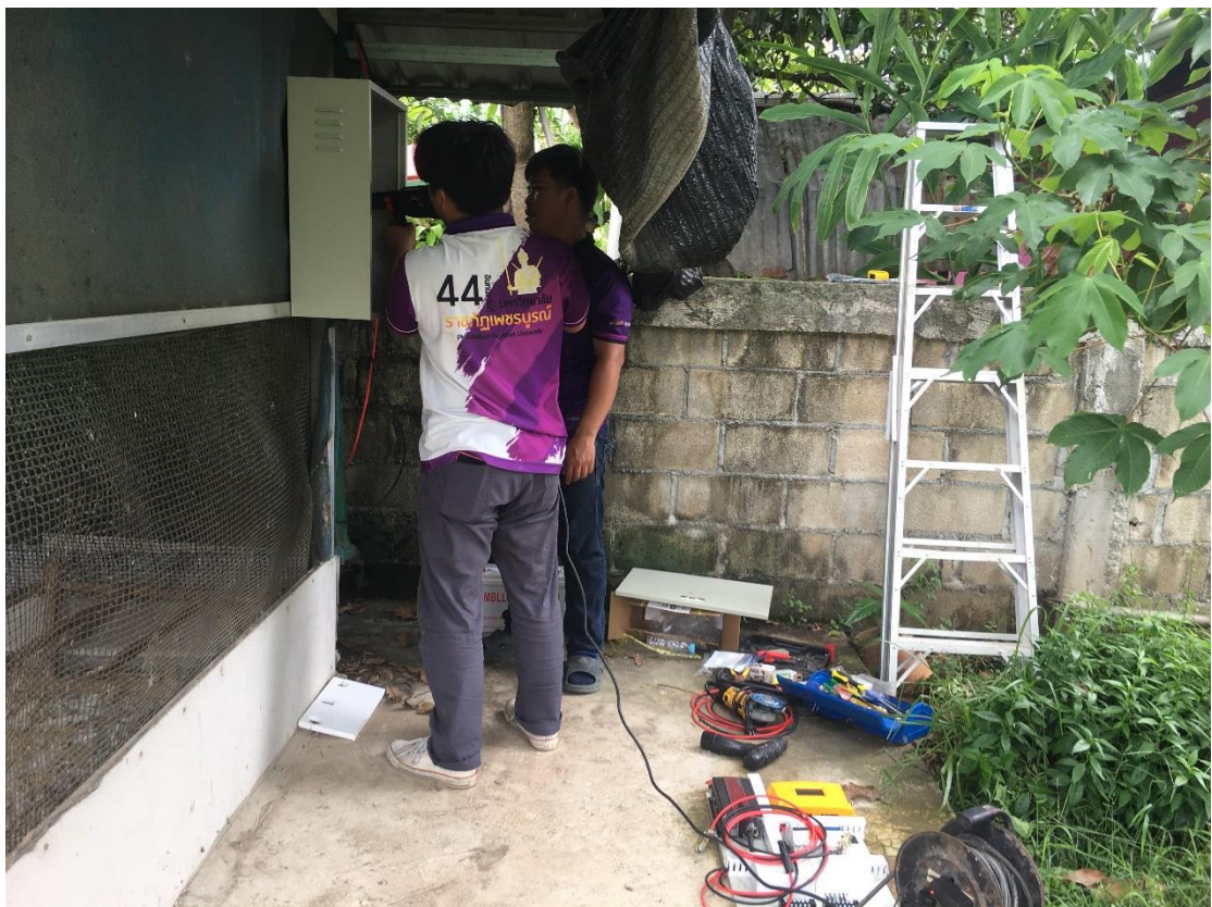
รูปที่ 4.12 การติดตั้งตู้ควบคุม
