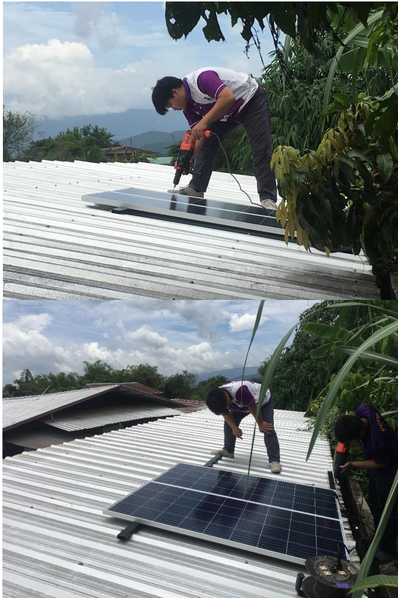
รูปที่ 4.10 การติดตั้งแผงโซลาร์เซลล์
