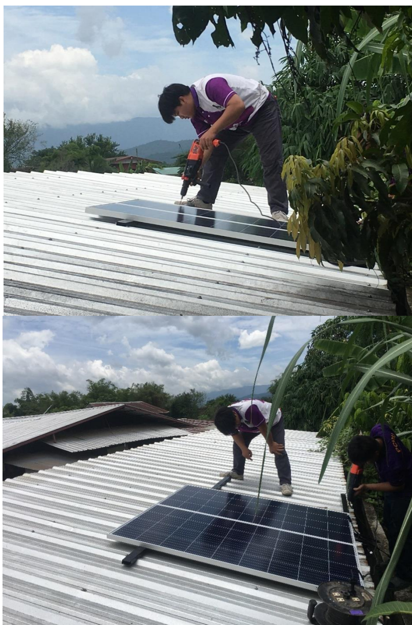
ภาพที่ 4.13 การติดตั้งแผงโซลาร์เซลล์
