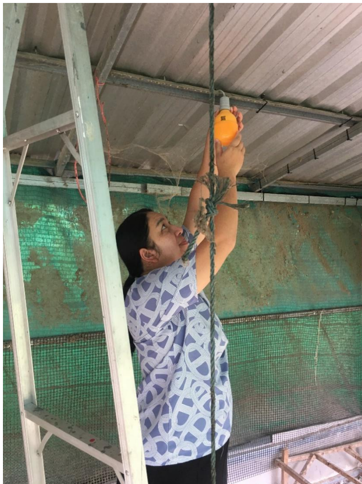
ภาพที่ 4.14 การติดตั้งหลอดไฟในคอกเลี้ยงลูกไก่
