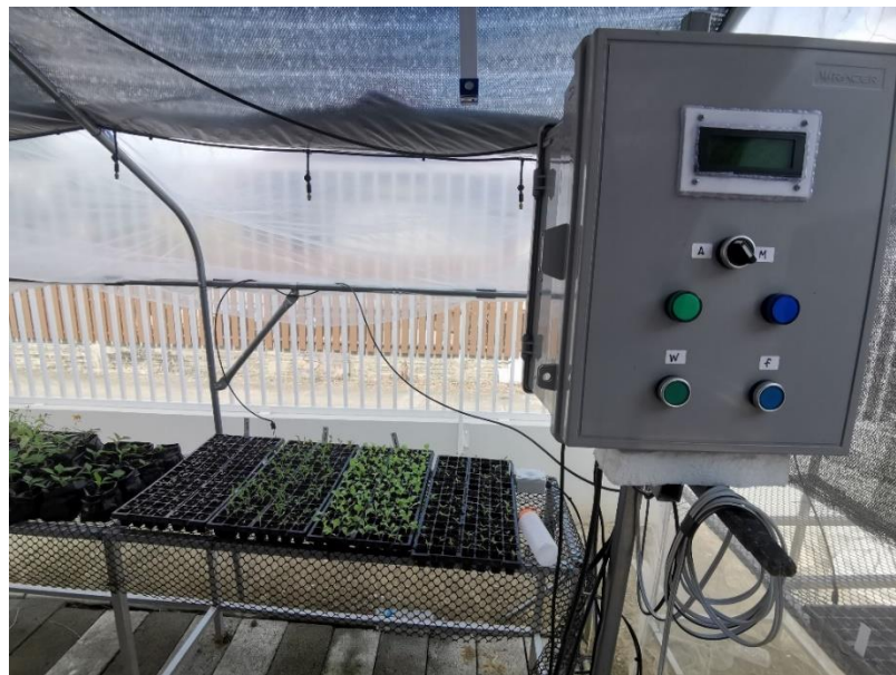
รูปที่ 3-7 การติดตั้งกล่องควบคุมการทำงานของโรงเรือนอัจฉริยะ
