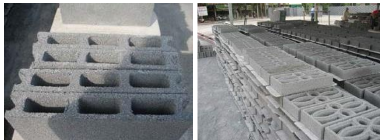
รูปที่ 2.1 ลักษณะของบล็อกชนิดรับน้ำหนักและไม่รับน้ำหนัก [4]
