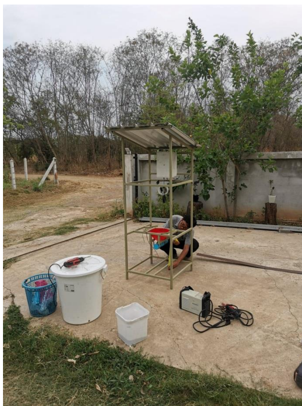
ภาพที่ 3.7 การติดตั้งกล่องควบคุมกับโครงเหล็กสำหรับยึดอุปกรณ์
