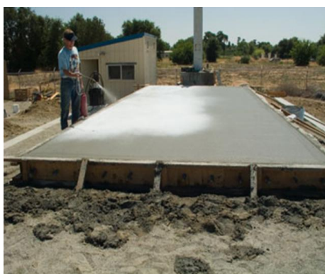
ภาพที่ 2.9 ภาพถ่ายการใช้สารเคมีเคลือบผิวคอนกรีต
