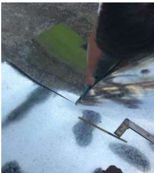
ภาพที่ 3.13 วัดขนาดแผ่นสังกะสีเรียบและตัดแผ่นสังกะสีเรียบ
