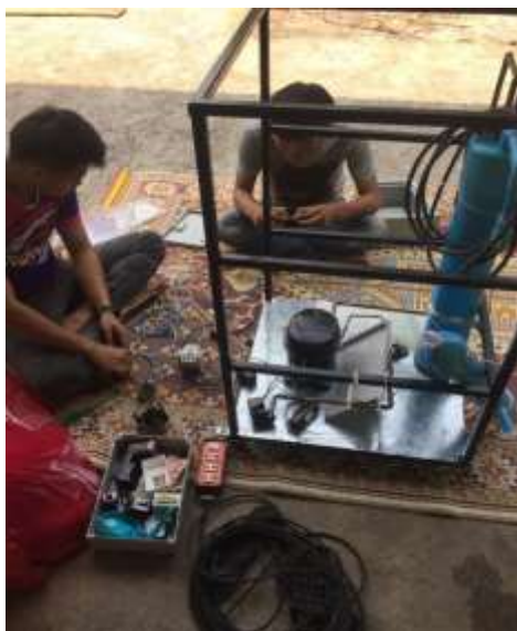
ภาพที่ 3.12 การติดตั้งอุปกรณ์เข้ากับโครงสร้าง
