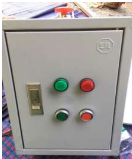
ภาพที่ 3.18 เจาะรูเพื่อวางตำแหน่ง ของ ไฟลอตแลมป์ และ สวิตช์ควบคุม
