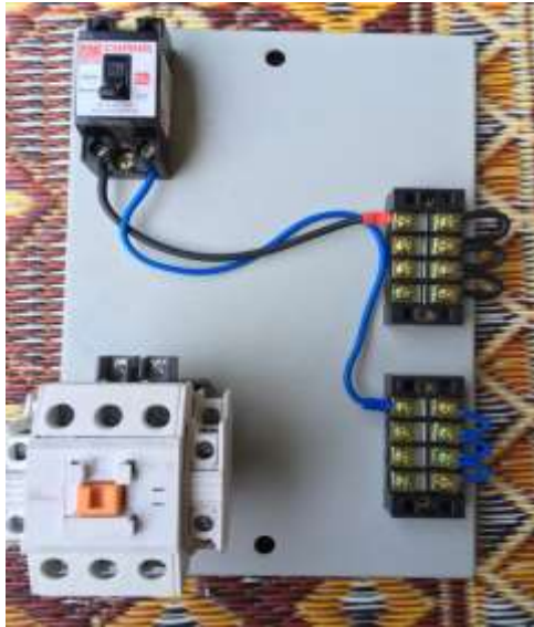
ภาพที่ 3.20 การวางตำแหน่งและติดตั้ง อุปกรณ์ควบคุม และป้องกัน
