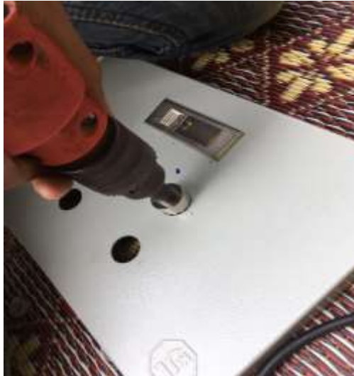
ภาพที่ 3.18 เจาะรูเพื่อวางตำแหน่ง ของ ไฟลอตแลมป์ และ สวิตช์ควบคุม
