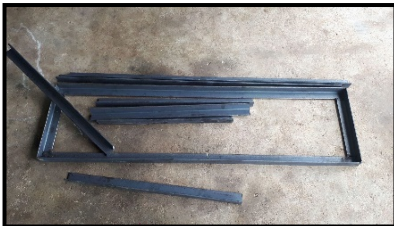
ภาพที่ 4-13 แสดงเหล็กทำโครงสร้าง
