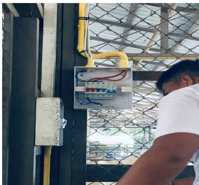
รูปที่ 4.8 การเดินสายไฟฟ้าและติดตั้งจุดจ่ายไฟเพื่อจ่ายไฟสำหรับโหนดในฟาร์ม
