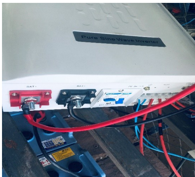
รูปที่ 4.7 การติดตั้งชุด Charger
