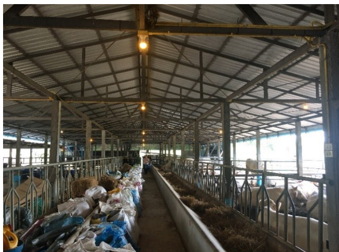
รูปที่ 4.19 การทดสอบจ่ายและการทำงานระบบส่องสว่างไฟโล่แมลง
