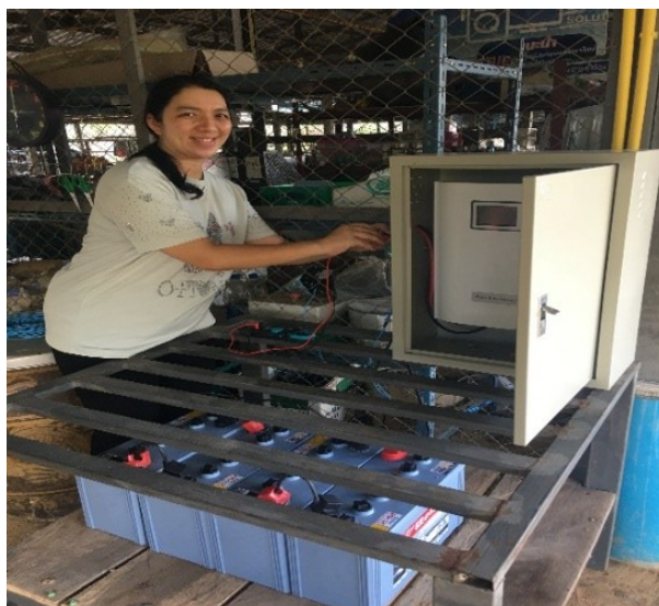
รูปที่ 4.15 การทดสอบระดับแรงดันระบบโซลาร์เซลล์ก่อนจ่ายไปยังโหลดในระบบ
