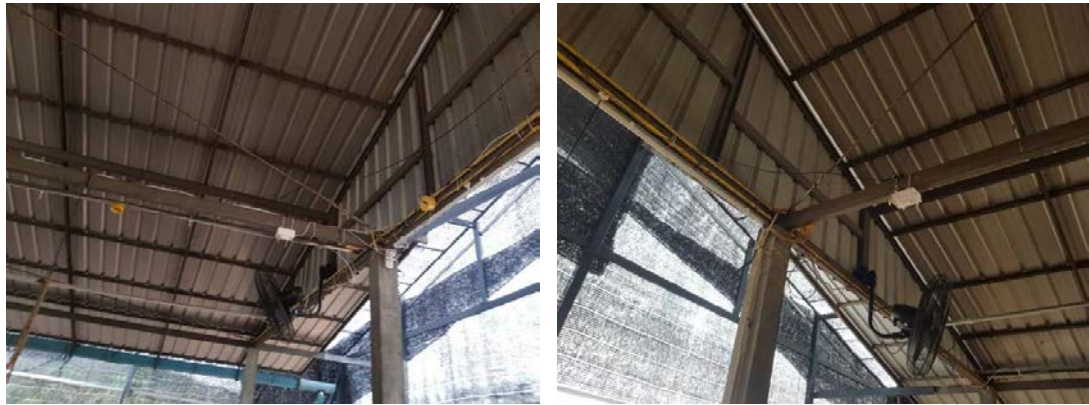
รูปที่ 3-32 การติดตั้งกล่องเซนเซอร์AM2302 บริเวณคานใต้หลังคาโรงเรียน
