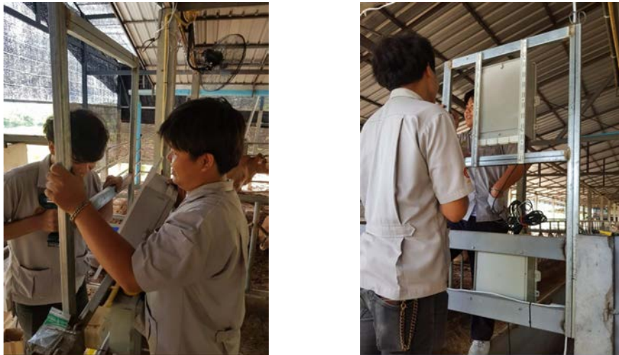
รูปที่ 3-35 การติดตั้งโครงเหล็กสำหรับยึดตู้ชุดอุปกรณ์ควบคุม อุปกรณ์เชื่อมต่อสัญญาณอินเทอร์เน็ตไร้สาย และตู้ปั๊มพ่นหมอก
