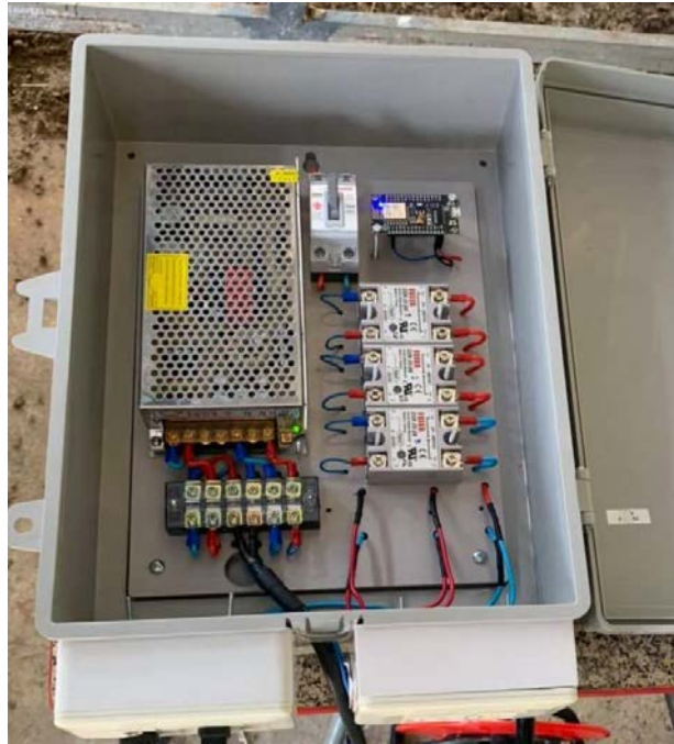
รูปที่ 3-30 การประกอบแผงวงจรลงในตู้ควบคุม
