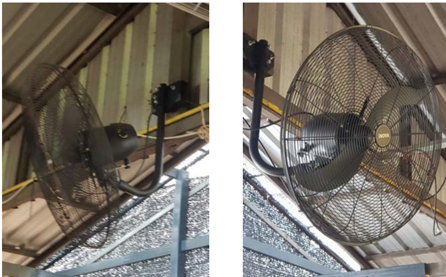
รูปที่ 3-33 การติดตั้งพัดลมโรงเรียน
