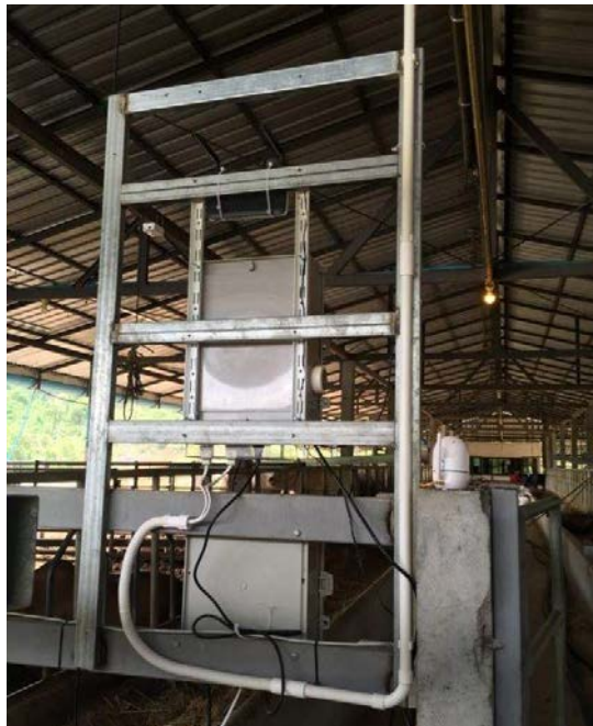
รูปที่ 3-37 การเดินสายร้อยท่อของระบบจากตู้ควบคุมไปยังเซนเซอร์และระบบไฟฟ้า
