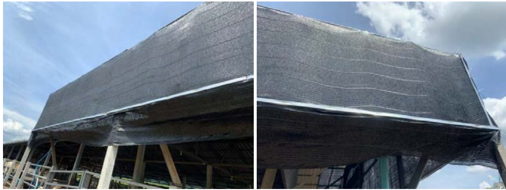
รูปที่ 3-38 การติดตั้งผ้าแสลนพรางแสงบริเวณโรงเรียน
