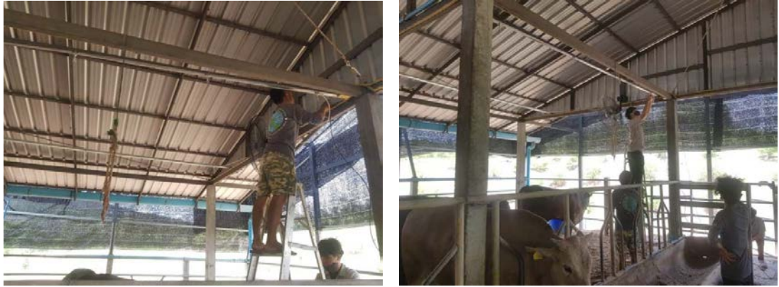
รูปที่ 3-34 การติดตั้งท่อน้ำพร้อมหัวพ่นหมอกบริเวณคานใต้หลังคาโรงเรือน
