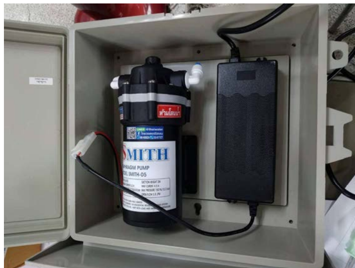
รูปที่ 3-31 การประกอบปั๊มพ่นหมอกลงในตู้ควบคุม
