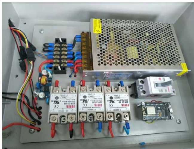
รูปที่ 3-41 การประกอบแผงวงจรลงในตู้ควบคุมระบบให้น้ำ
