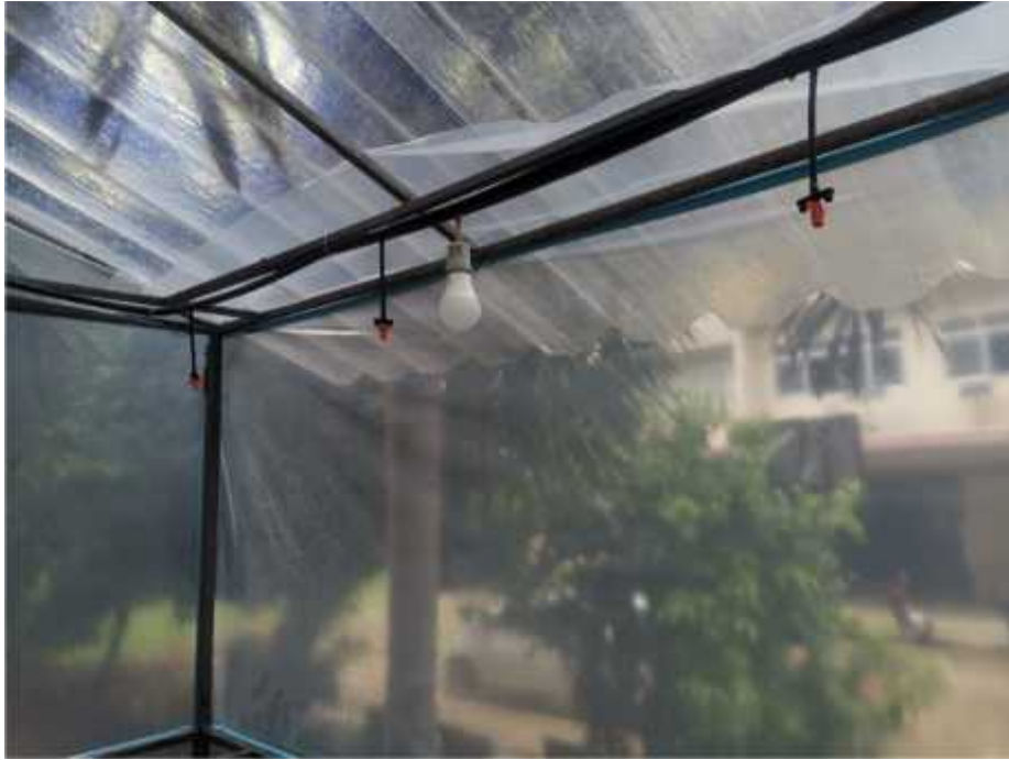
รูปที่ 3-9 การติดตั้งหลอดไฟและระบบพ่นหมอก
