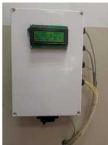
รูปที่ 3-7 การติดตั้งกล่องควบคุมการทำงานของโรงเพาะชำอัตโนมัติ
