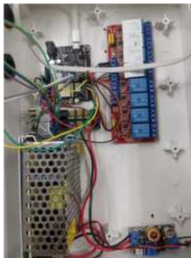
รูปที่ 3-6 การติดตั้งอุปกรณ์ในกล่องควบคุมการทำงานของโรงเพาะชำอัตโนมัติ
