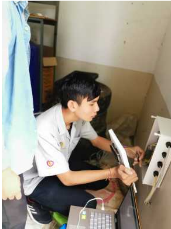
การติดตั้งกล่องควบคุมโดยกลุ่มนักศึกษาในรายวิชาปฏิบัติการเครือข่ายคอมพิวเตอร์
