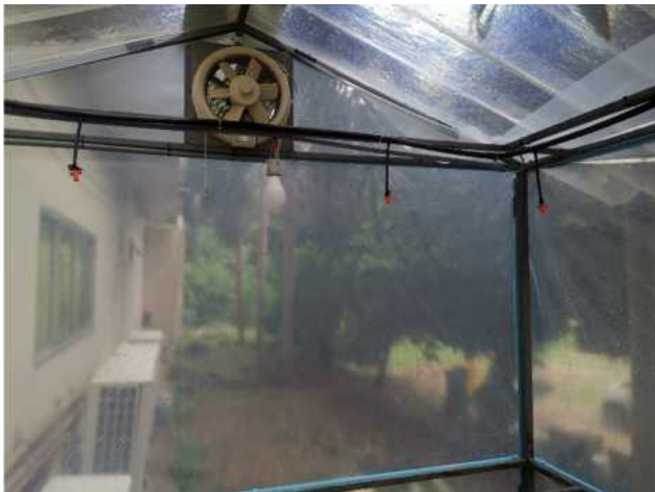
รูปที่ 3-10 การติดตั้งพัดลมระบายความชื้น
