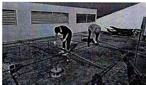
ภาพที่ 3.10 การประกอบหลังคาโรงเรือนระบบควบคุมการปลูกพืชไร้ดินแบบอัตโนมัติ
