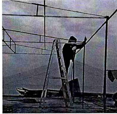
ภาพที่ 3.11 การประกอบเสาโรงเรือนระบบควบคุมการปลูกพืชไร้ดินแบบอัตโนมัติ
