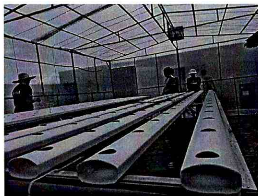
ภาพที่ 3.13 นำรางปลูกผักมาวางภายในโรงเรือน
