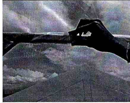
ภาพที่ 3.14 การติดพลาสติกใสบนหลังคาโรงเรือน
