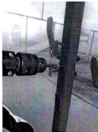
ภาพที่ 3.12 การติดตั้งล้อย่อมรอบโรงเรือนระบบควบคุมการปลูกพืชไร้ดินแบบอัตโนมัติ
