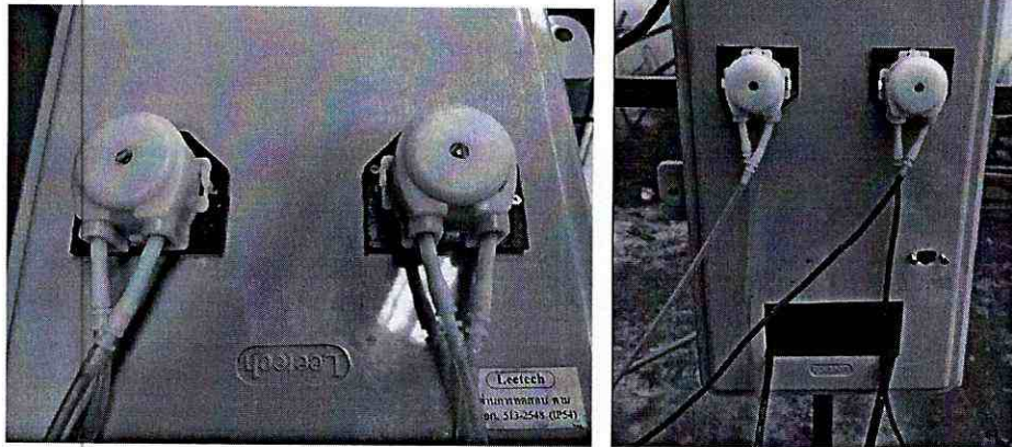
ภาพที่ 3.24 การติดตั้งมอเตอร์ดูดปุ๋ย
