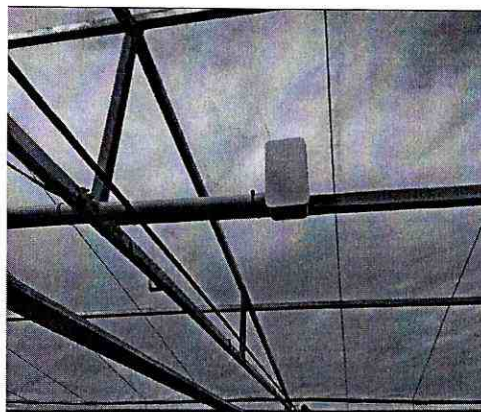
ภาพที่ 3.24 การติดตั้งเซนเซอร์แสง
