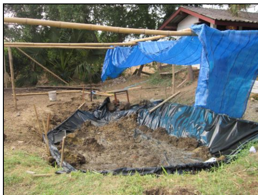
บ่อเลี้ยงปลาระหว่างดำเนินการขุด
