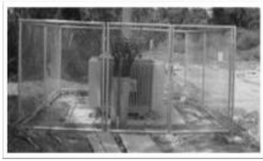
รูปที่ 2-1 หม้อแปลงแบบลานและการติดตั้งบนเสา
