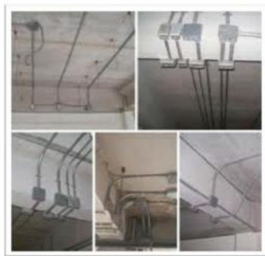
รูปที่ 2-4 การเดินสายร้อยท่อ/ราง
