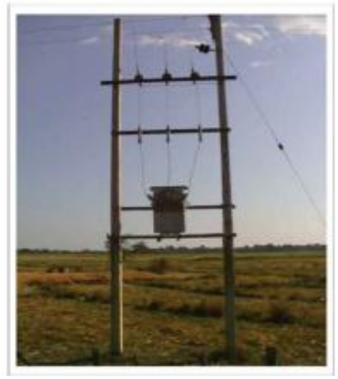
รูปที่ 2-1 หม้อแปลงแบบลานและการติดตั้งบนเสา
