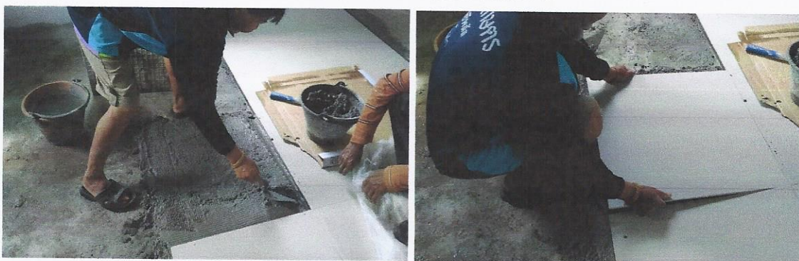
รูปที่ 4.12 แสดงการปูกระเบื้อง แบบปูเต็มแผ่น
