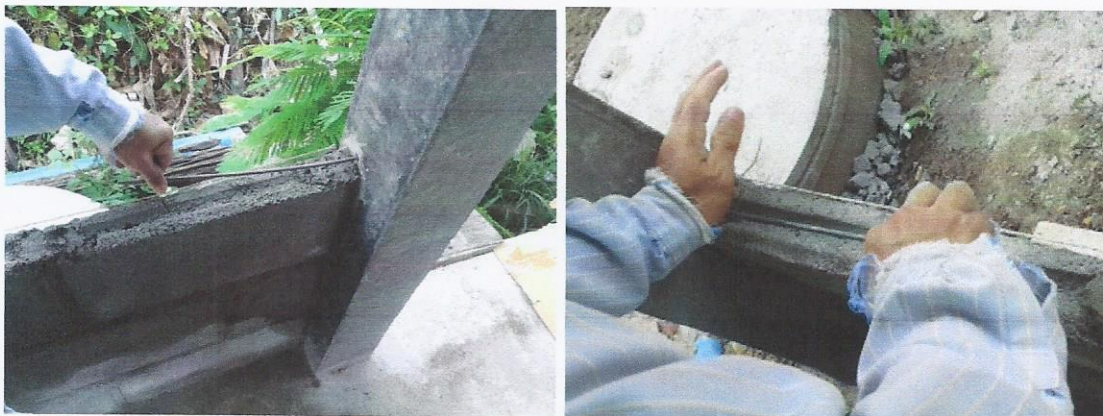
รูปที่ 4.6 แสดงการใส่เหล็กเสริม เหล็กหนวดกุ้งทุกชั้น เพิ่มความแข็งแรงของผนัง
