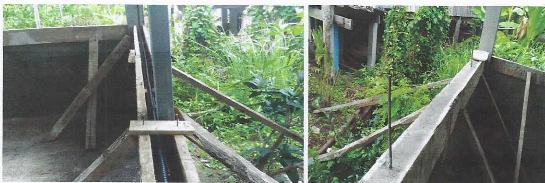
รูปที่ 4.7 แสดงการเสริมเหล็ก และเทคอนกรีตทับตลอดทั้งแนว (ทับหลัง)
