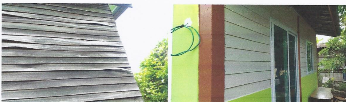
รูปที่ 4.5 แสดงการใช้วัสดุทำผนัง ระหว่างไม้เบญจพรรณ กับ ไม้สังเคราะห์เมอร์รา
