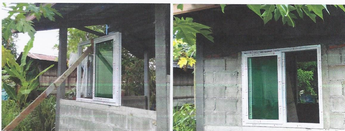
รูปที่ 4.9 การติดตั้ง หน้าต่าง UPVC แนวผนัง ยึดติดกับทับหลังคอนกรีต
