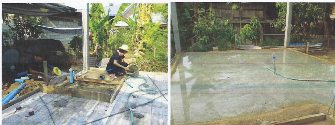
รูปที่ 4.11 การติดตั้งพื้นคอนกรีตสำเร็จรูป และการบ่มคอนกรีต
