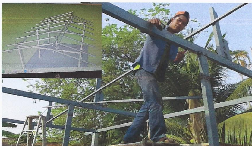
รูปที่ 4.3 การประกอบโครงหลังคา โดยใช้เหล็กรูปพรรณ ตามที่ออกแบบไว้
