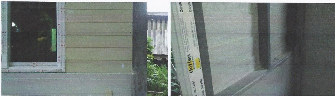
รูปที่ 4.8 แสดงการยึดแผ่นไม้ฉลอร้าด้วยตะปูเกลียวภายนอกอาคาร
