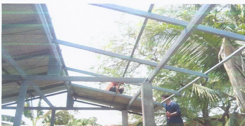
รูปที่ 4.4 แสดงการมุงหลังคา ด้วยแผ่นหลังคามะทัลชีท
