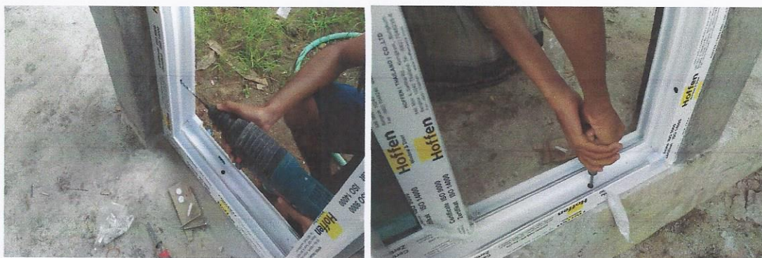
รูปที่ 4.10 แสดงการติดตั้ง ประตู UPVC ยึดติดกับทับหลังคอนกรีต
