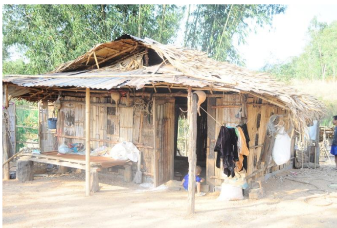
ภาพที่ 10 บ้านมั่งโบราณที่หมู่ 4 ตำบลเข็กน้อย อำเภอเข้าค้อ จังหวัดเพชรบูรณ์
