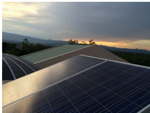
รูปที่ 3.10 ติดตั้งระบบโซลาร์เซลล์แบบสมบูรณ
