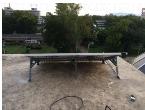
รูปที่ 3.5 การติดตั้งโซลาร์เซลล์
