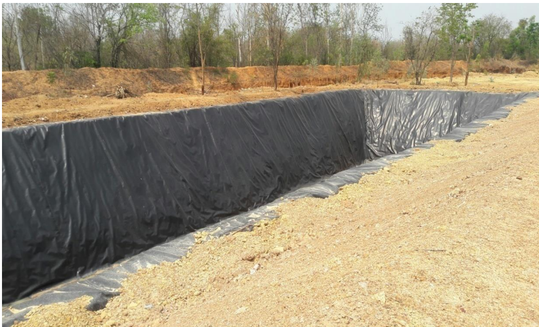
รูปที่ ข-3 การวางแผ่นกันซึมรองรับน้ำเสียจากขยะ
