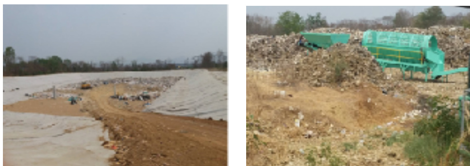
รูปที่ 4.5 บ่อจำกัดขยะบ่อที่ 1
