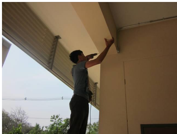
รูปที่ 3.11 การเดินท่อและติดตั้งแฮนดี้บล็อกซ์
