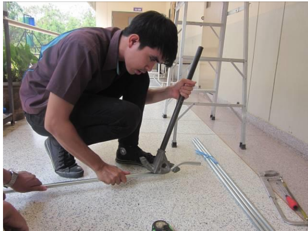
รูปที่ 3.10 การตัดท่อ
