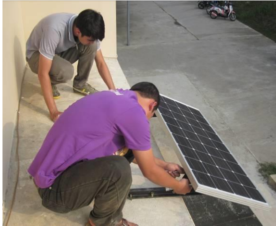
รูปที่ 3.8 ติดตั้งและปรับองศาของแผงโซลาร์เซลล์
