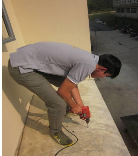
รูปที่ 3.6 เจาะรูยึดฐานแผงโซลาร์เซลล์
