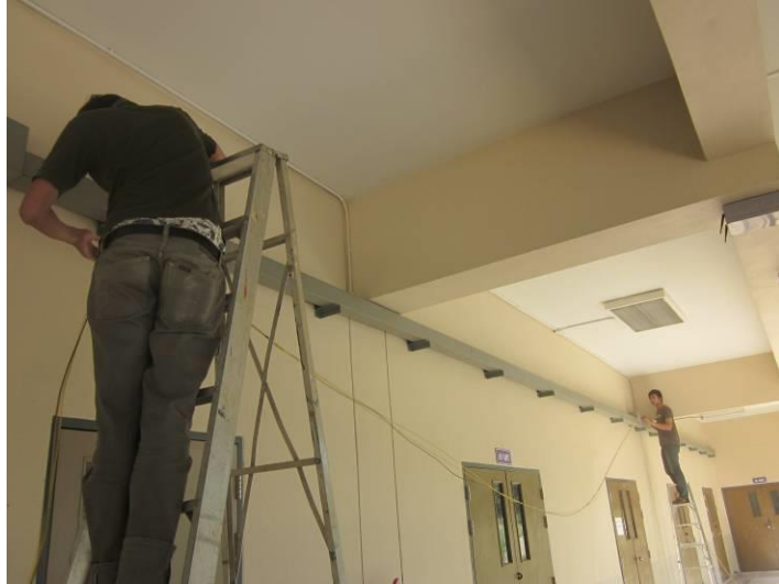
รูปที่ 3.14 นำสายเข้ารางไวร์เวย์
