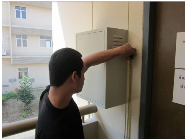
รูปที่ 3.12 ติดตั้งตู้ควบคุม
