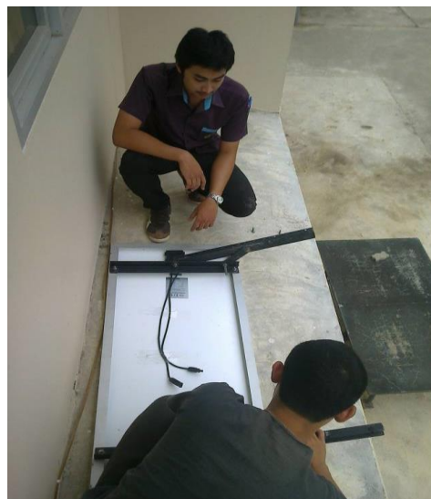
รูปที่ 3.7 ติดตั้งโครงสร้างฐานแผงโซลาร์เซลล์
