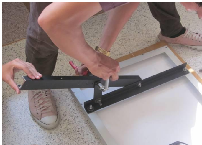
รูปที่ 3.5 ประกอบส่วนโครงสร้างฐานแผงโซล่าเซลล์
