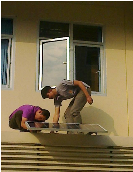
รูปที่ 3.9 การติดตั้งแผงโซลาร์เซลล์
